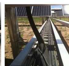
Conduit Raceway
